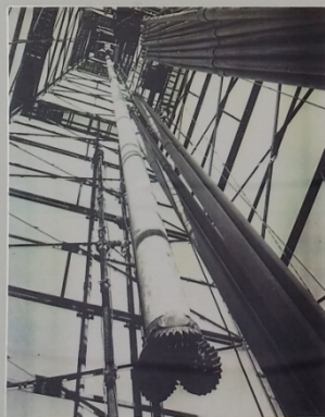
Trepan à molettes en place dans un derrick à Saint-Marcet.
