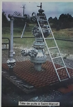
Tête de puits à Saint-Marcel
