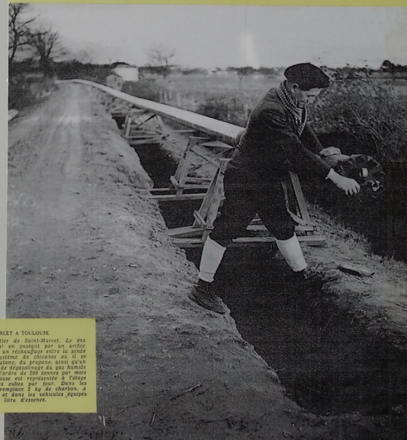
Travaux d'un gazoduc - Photo Yvon
