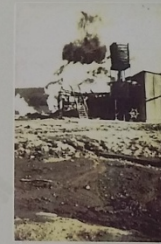
Incendie du puits SM 4 le jour.
