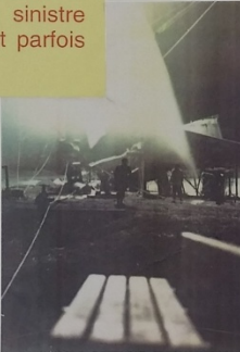
Incendie du puits SM 4, mise en place du dispositif d'extinction.
