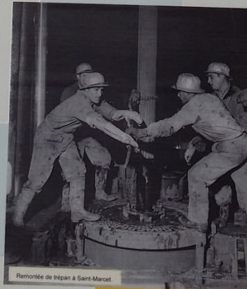
Remontée de trépan à Saint-Marcey
