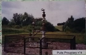
Puits Propriary n°4
