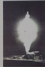
Incendie du puits SM 4 la nuit.
