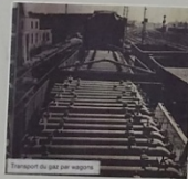
Transport du gaz par wagons
